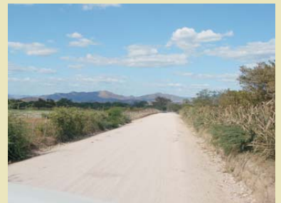
4.5 KM del Tramo Santa Ana de Yusquare-El Zapotillo en el municipio de Santa Ana en el departamento de Choluteca construidos con el financiamiento de la Cuenta del Milenio.
